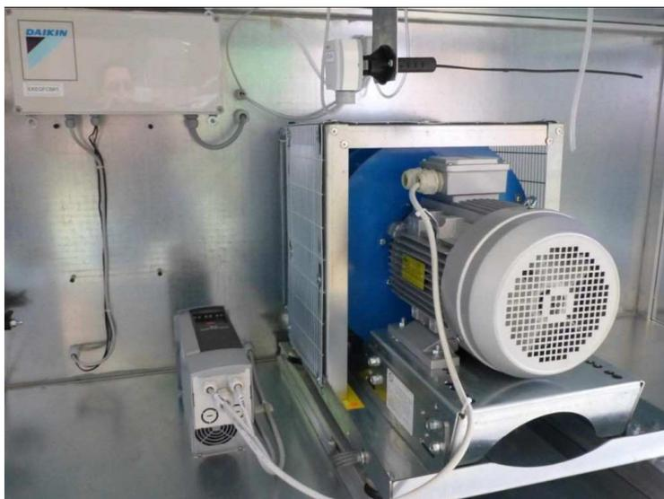
Figura 5 – Vista dos componentes internos da UTA
