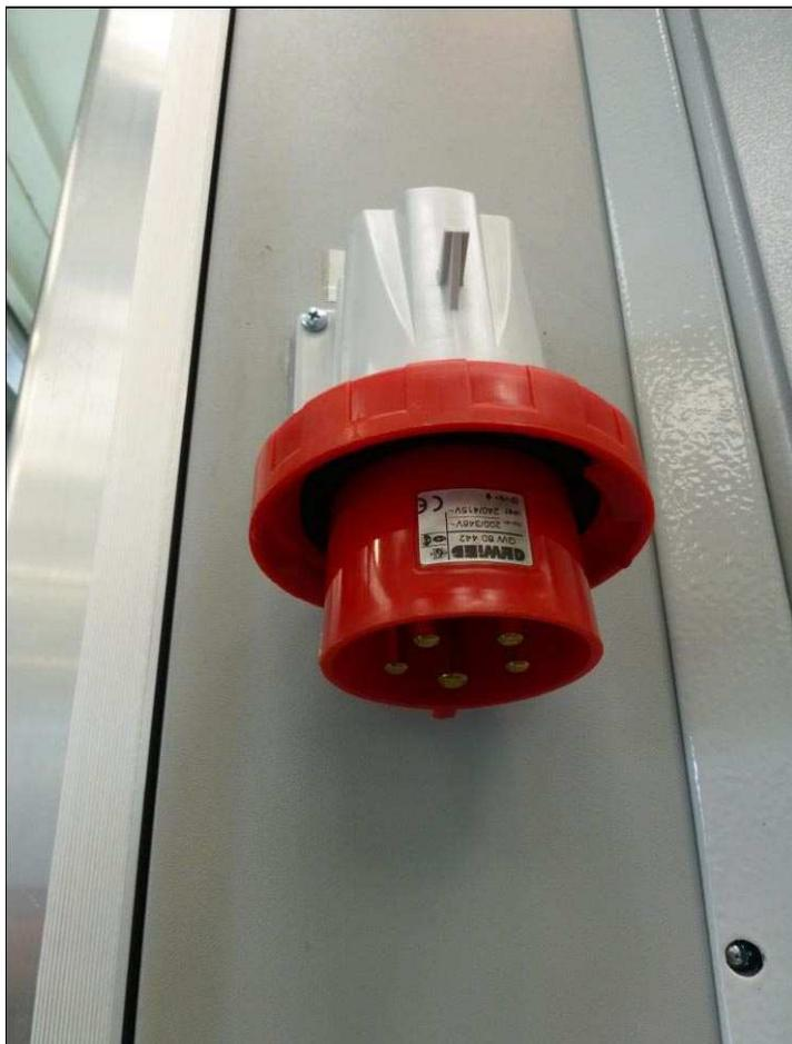
Figura 7 – Conexão externa de energia da UTA
