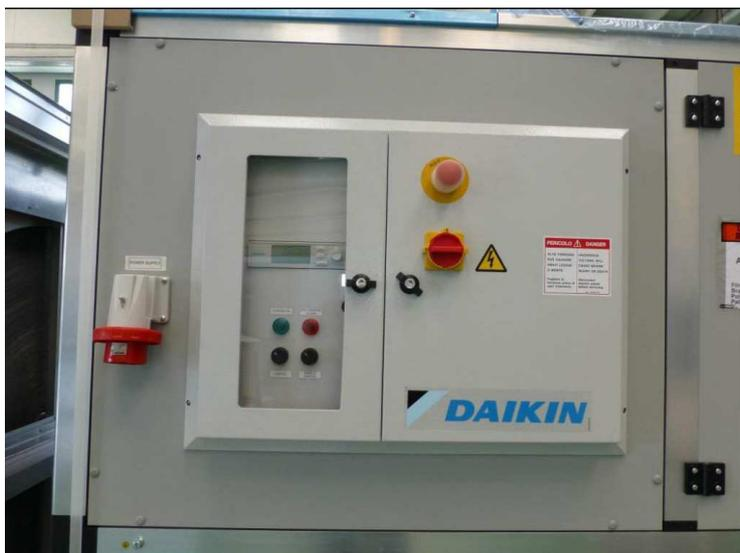
Figura 3 – Painel elétrico integrado ao Air Handler (AHU)
