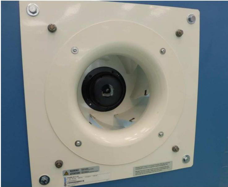
Figura 11 – Vista frontal de um plenum fan
