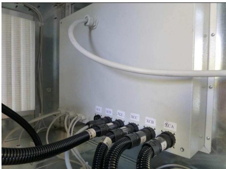
Figura 4 – Vista traseiro do painel elétrico integrado à AHU
