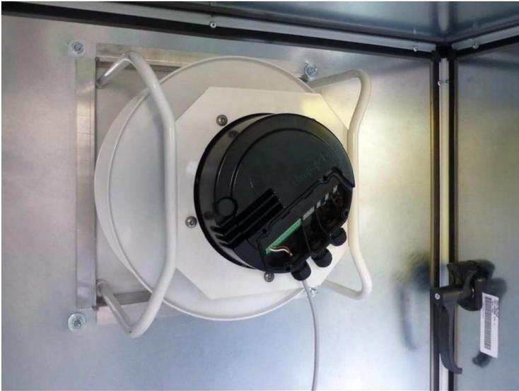
Figura 12 – Vista traseira de um plenum fan com motor EC
