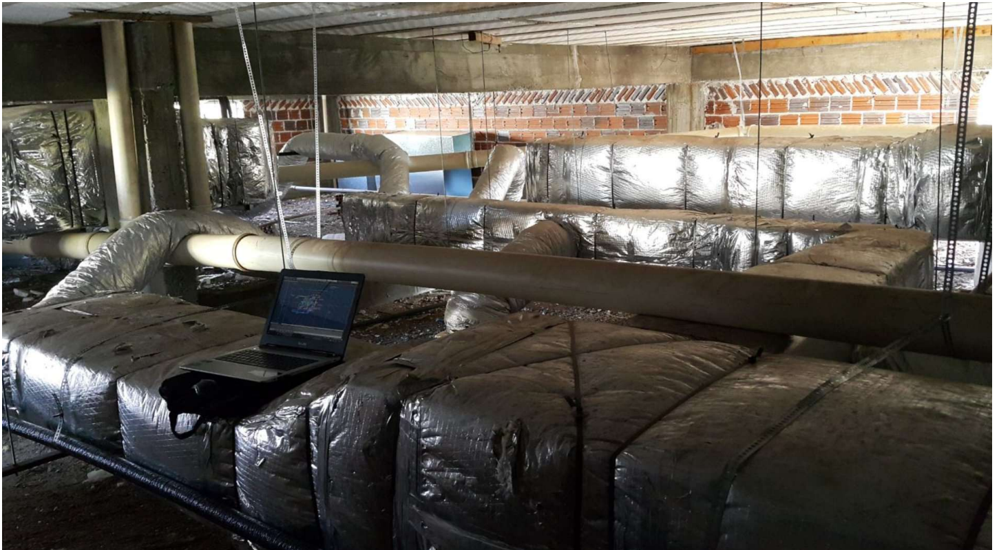
Entreforros de uma área hospitalar - fonte: Adrifercos
